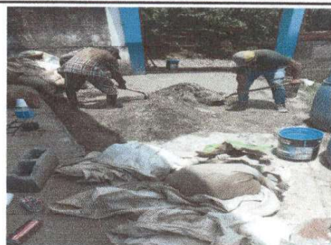
Foto 8: Reparación de banqueta de concreto.
