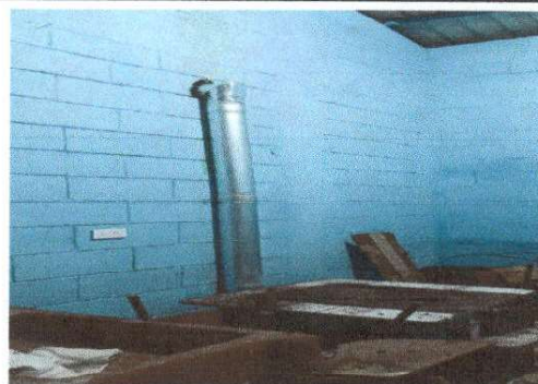
Foto 10: Sustrucción de chimenea de metal cocina.
