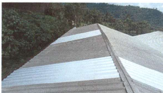
Foto 9: Sustrucción de láminas troqueladas.
